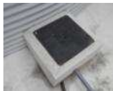
Drain manhole
