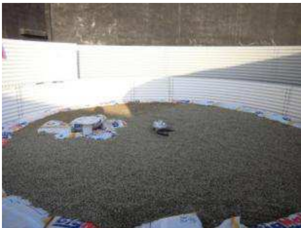
Keramzytowa izolacja dna
