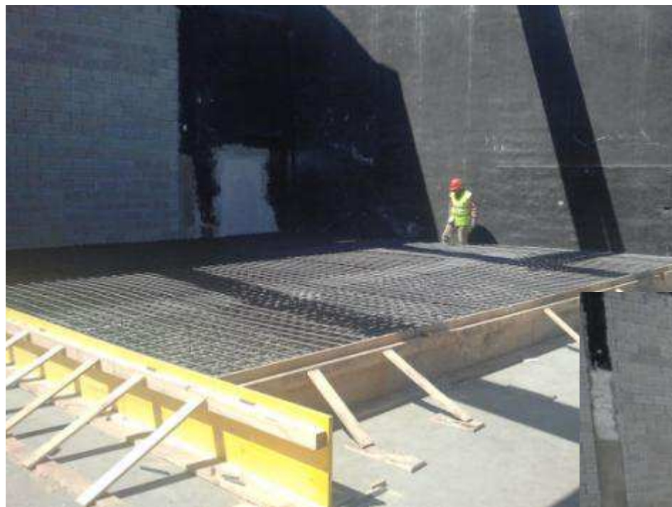
Zbrojenie fundamentu
