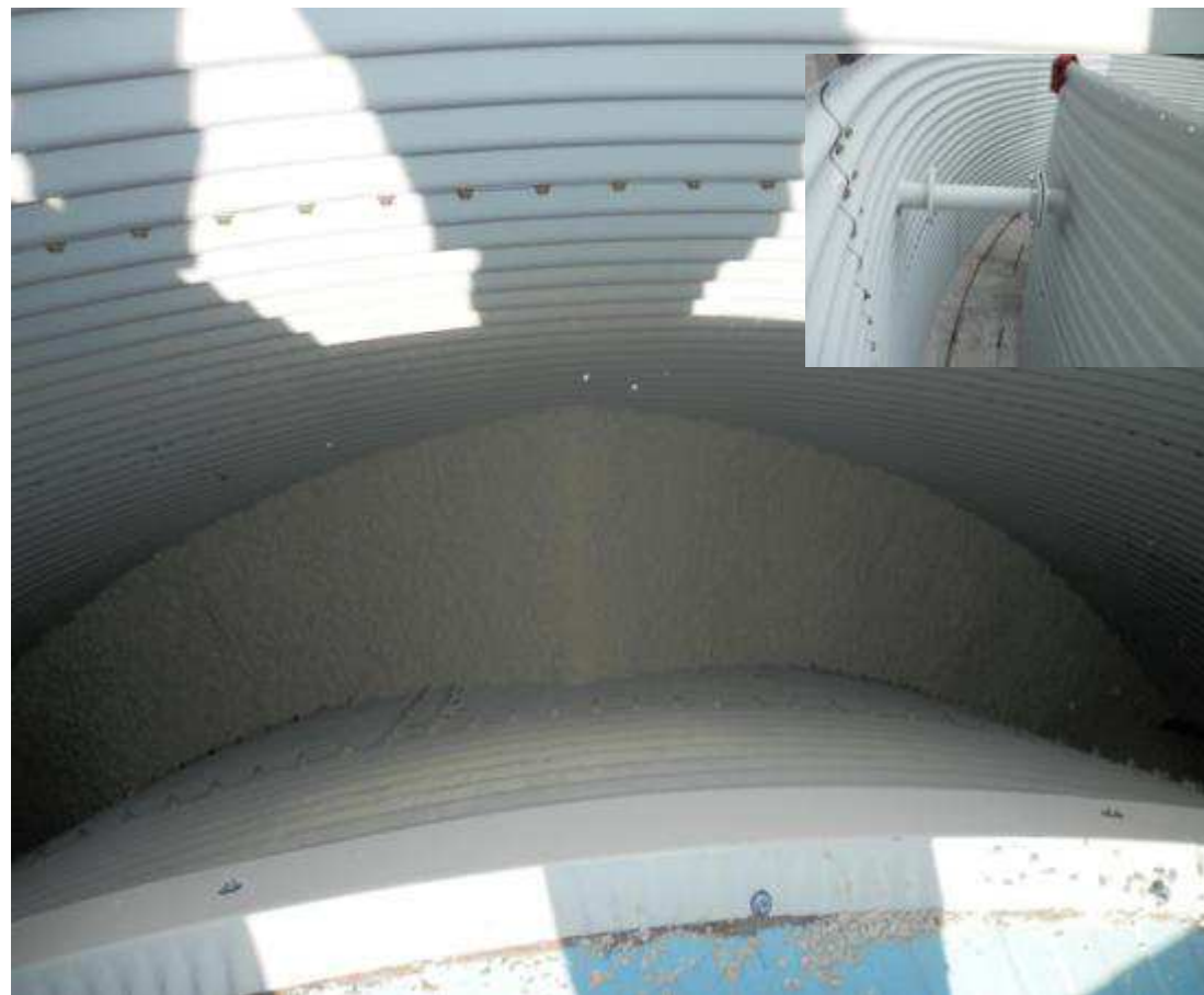
Granulowany PUR między zbiornikami (boczna i górna część)
