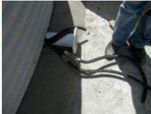
Przewodzenie na podstawie temperatury zbiornika i czujnika ciśnienia.
